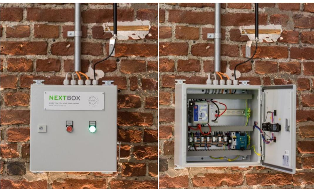
Die Next Box dient als dezentrale Steuerungs- und Kommunikationseinheit: Sie sorgt für die Verbindung der angeschlossenen Anlagen mit der Zentrale des Virtuellen Kraftwerks in Köln. Durch die Bündelung im „Next Pool“ werden die Anlagen zentral steuerbar wie ein einziges Kraftwerk.
