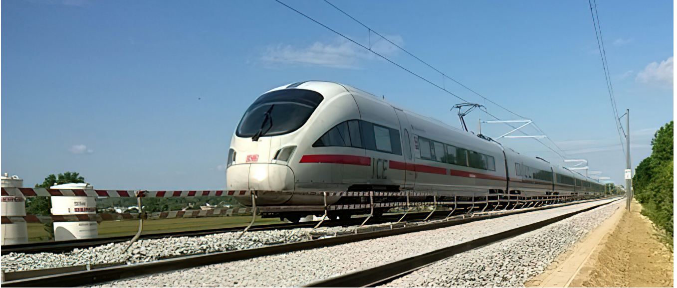
Ausbaustrecke Deutsche Bahn München-Ingolstadt
