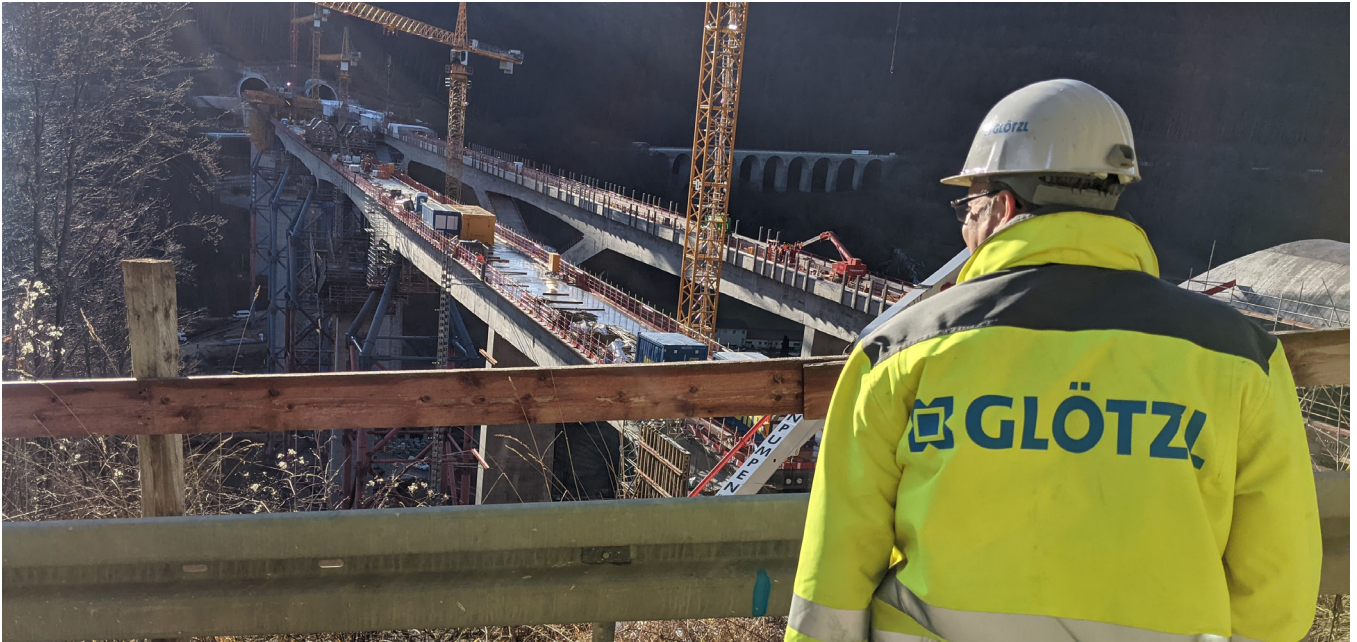
Deutsche Bahn Neubaustrecke Stuttgart-Ulm, Filstalbrücke
